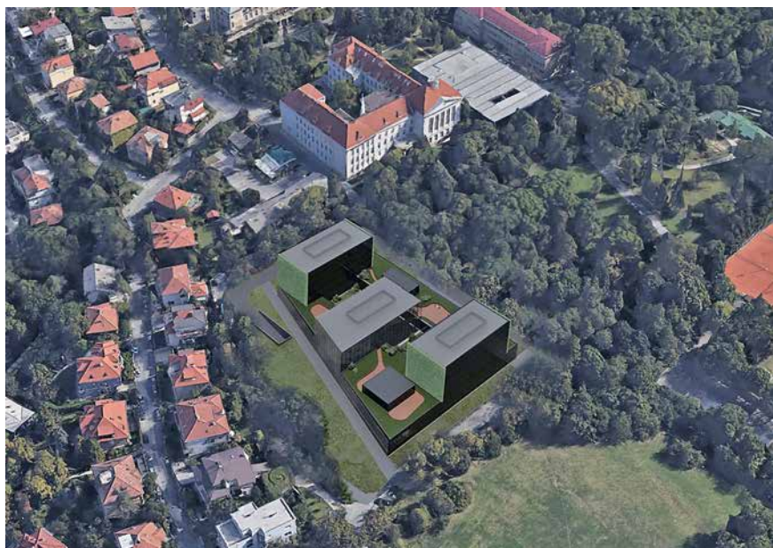
Slika 2. Fotomontaža pogleda iz zraka na zgradu BIMIS-a na adresi Šalata 4. Posebna pažnja posvećena je uklapanju zgrade u okolno zelenilo Šalate zelenim površinama na krovu prizemlja te zelenim oblogama uzdignutih krila zgrade.
