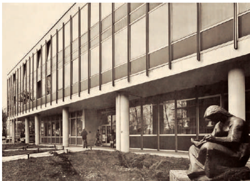
Novi dekanat, Šalata 3, prije obnove.
