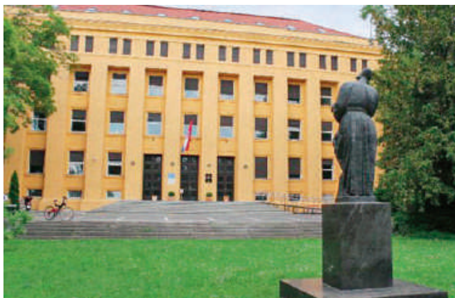
▼ Škola nakon obnove.
