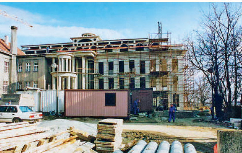
Zgrada temeljnih medicinskih znanosti – građevinski radovi oko 1995. godine.
