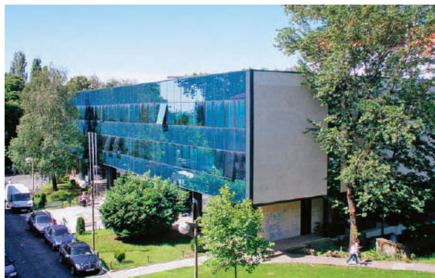
▼ Dekanat – nakon obnove, 2006. godine.
