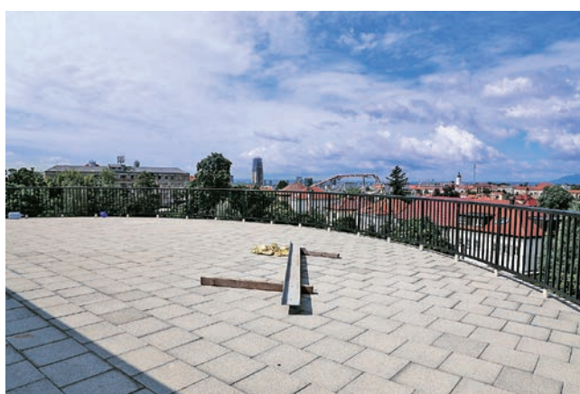
Pogled na veliko fakultetsko gradilište sa zgrade Zavoda za patologiju
