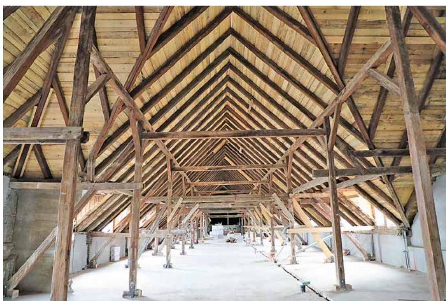
Krovište zgrade staroga dekanata, Šalata 3
