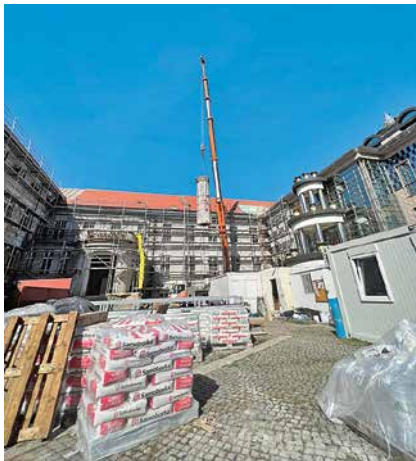
Priprema za potpunu transformaciju prostora
