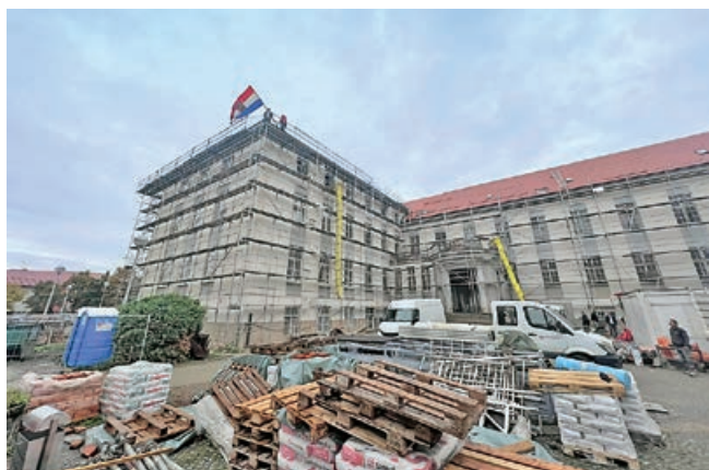
Postavljeno je krovništvo
